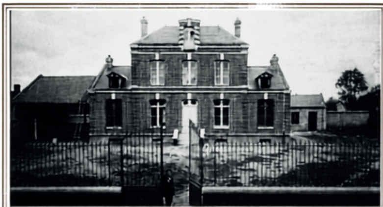
Mairie École de Villers-sur-Thère, façade en construction 1906-1907 actuellement accueil périscolaire "Ô Mil Couleurs". Photo de Charles COMMESSY.
